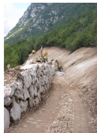
Merlon de protection à Aste-Béon
