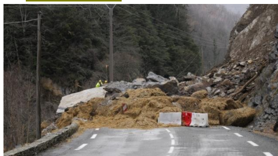
Eboulement en vallée d'Aspe en 2008 © Gilles Daid
