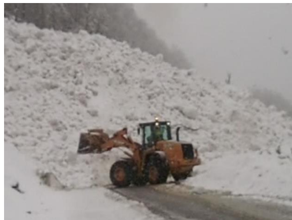
La route du Pourtalet en avril 2014
