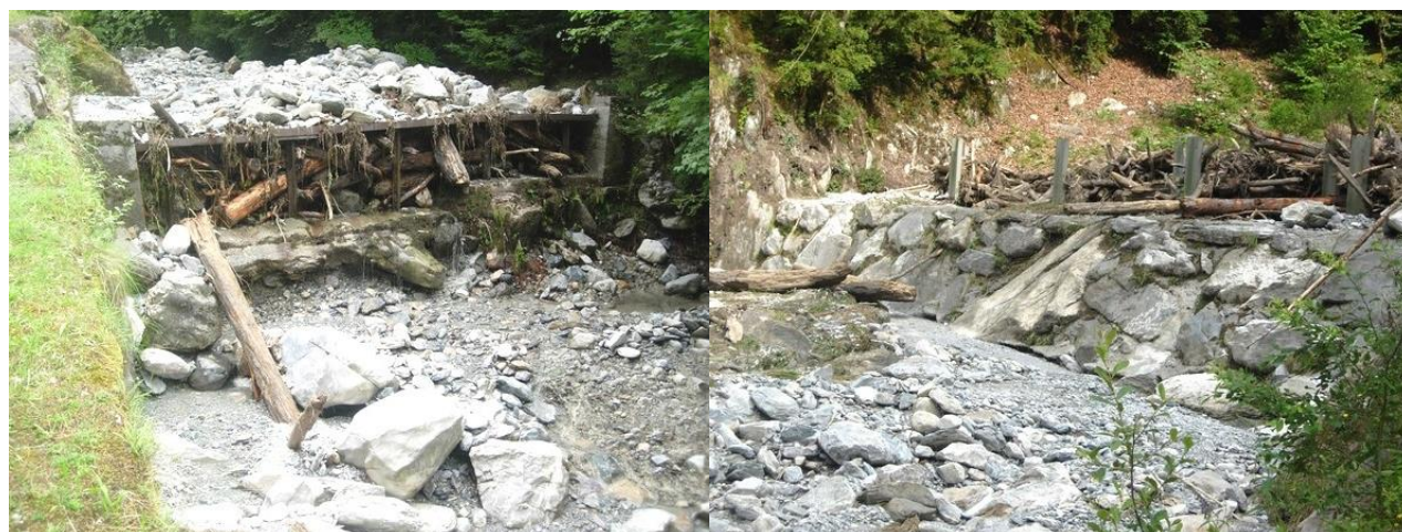
Pièges à matériaux dans le lit du torrent la Sourde (Eaux-Bonnes) crue du 6 août 2009
