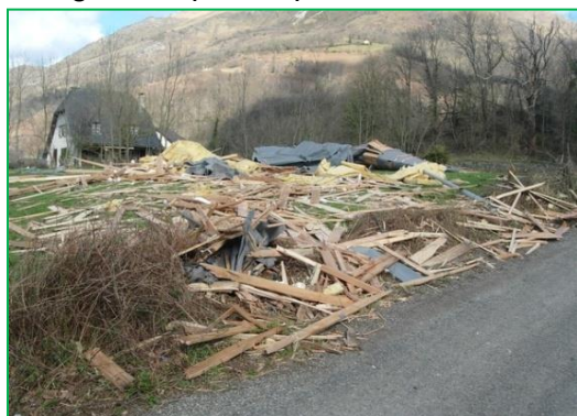
Toiture envolée à Bedous en 2010
