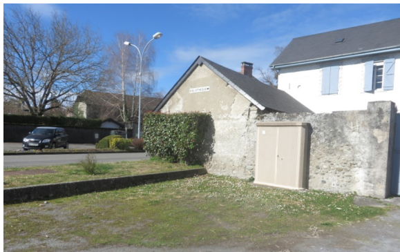
Des trottoirs et parkings reverdissent pour limiter les travaux de désherbage.
